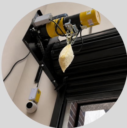
Substituição de Motores
